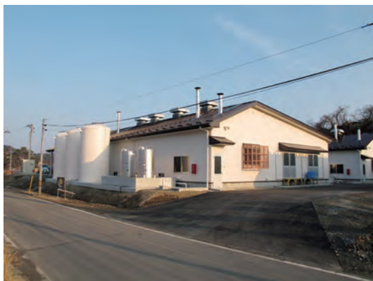
写真1 海苔生産グループ「月光」の工場外観
