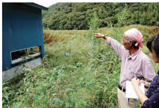
写真2 釜谷溜池ポンプ小屋
