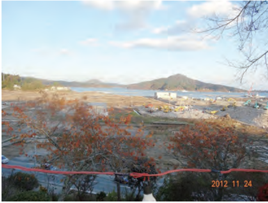
写真1 瓦礫の撤去と地盤沈下の対策の高上げ工事が進む。
