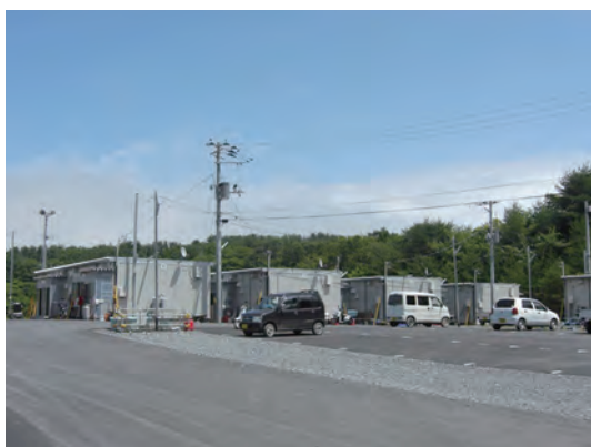
写真1 女川町出島仮設住宅
