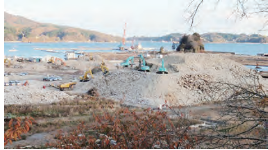
写真2 工場などを建設するにせよかなりの高上げが必要とされる。
