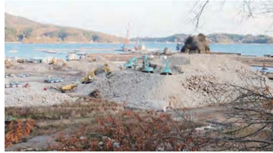
写真2 工場などを建設するにせよかなりの高上げが必要とされる。
