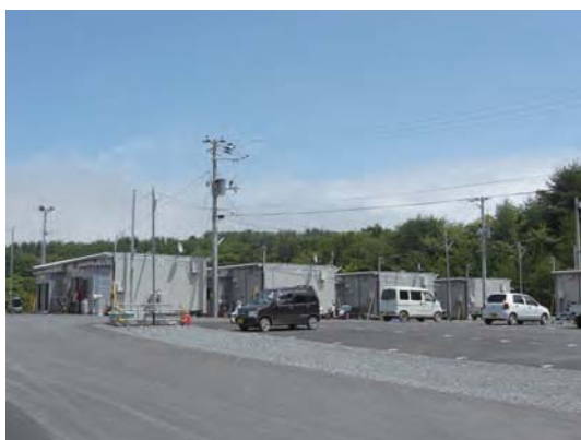
写真1 女川町出島仮設住宅
