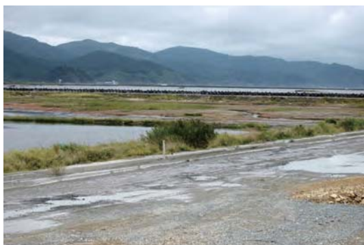
写真1 排水中の北上川河口
